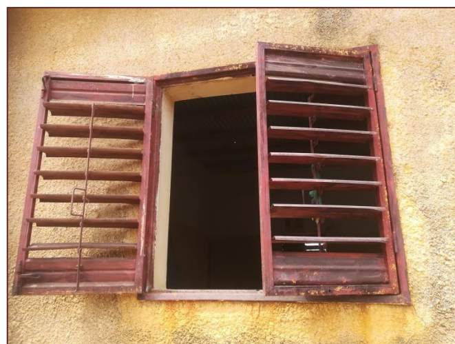
Fenêtres et portes extérieures et
