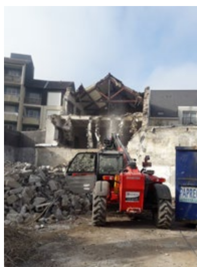
Démolition préalable aux travaux, BSR Barbin
