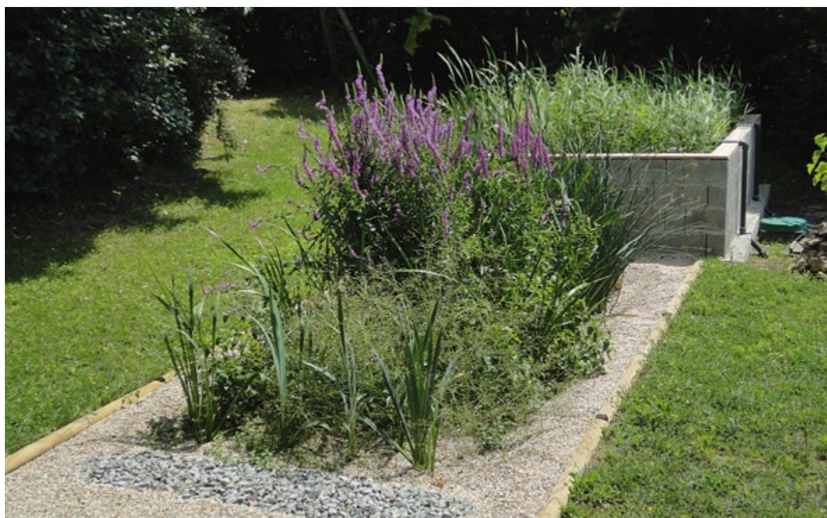
Filtres plantés, un assainissement non collectif naturel
