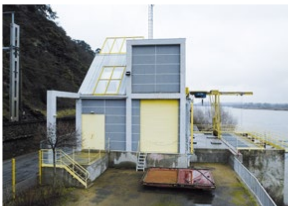
Station de pompage de Mauves sur Loire
