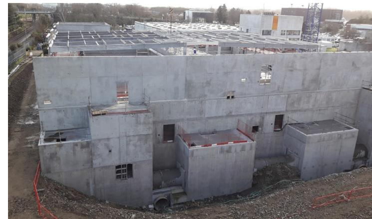
*Usine de la Roche : nouveaux filtres à sable et canalisations de transfert des eaux traitées*
