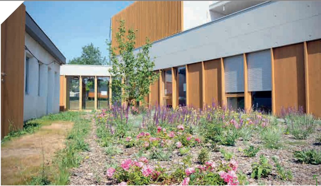
Agrandie et rénovée entre 2020 et 2022, l'école des Buzardières bénéficie de normes environnementales exigeantes.
