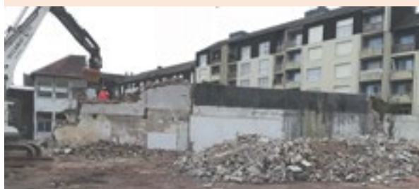
Démolition des anciens ateliers Normands
