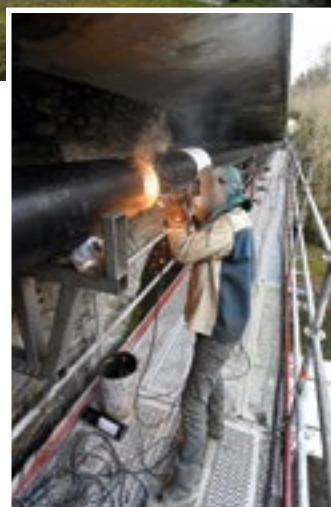
Renouvellement canalisation en encorbellement - pont de la Noué Verrière (La Chapelle-sur-Erdre)
