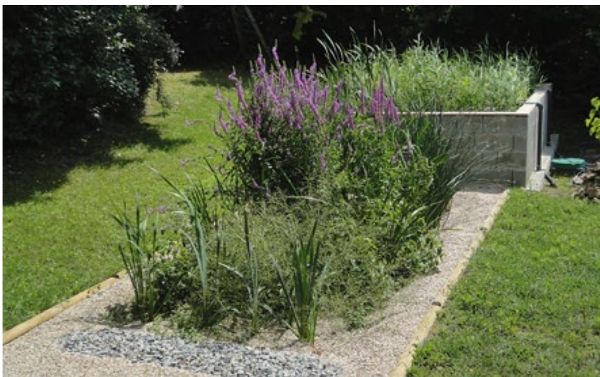
Filtres plantés, un assainissement non collectif naturel
