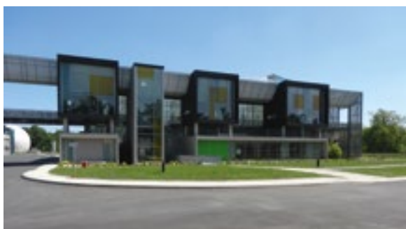
Station d'épuration Petite-Californie
