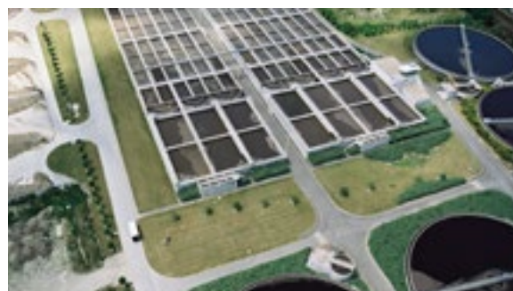
Station d'épuration de Tougas
