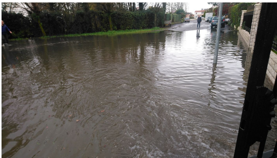
Inondations rue des Ormes, Vertou (été 2020)
