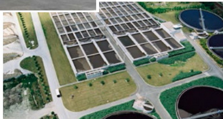
Station d'épuration de Tougas
