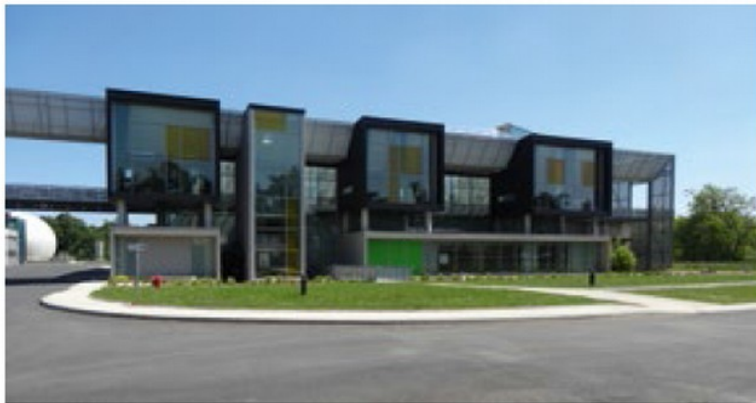
Station d'épuration Petite-Californie
