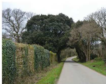
3- La Coutelière - murs maçonnés anciens
