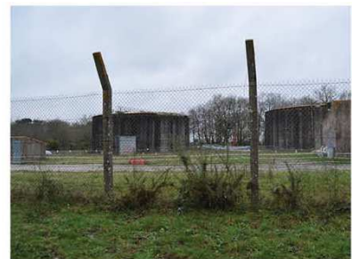
4- Réservoirs (commune de Couëron)
