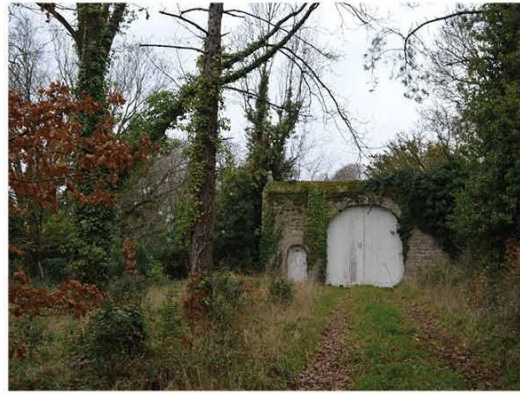
6 – Porche d'accès au manoir - Détail.
