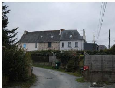
9-Bâti ancien - hameau de la Turbannière
