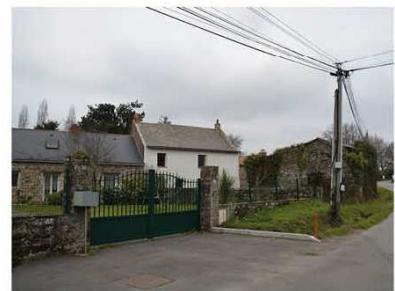
7- Bâti ancien - hameau de la Turbannière
