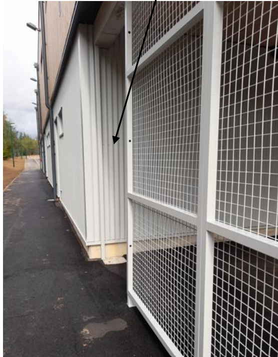
Le local onduleur sera sous forme d'une armoire grillagée installée à cet emplacement
