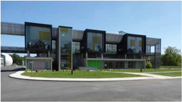
Station d'épuration Petite-Californie
