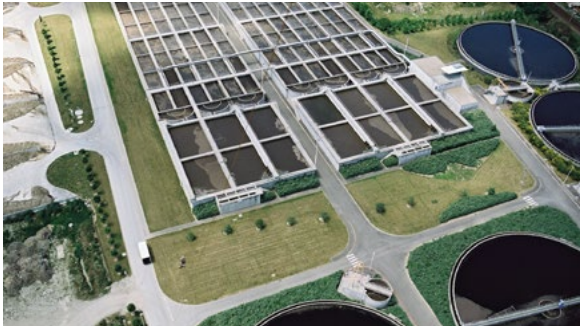
Station d'épuration de Tougas
