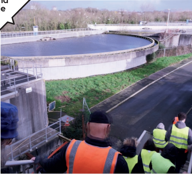
Visite dans les coulisses de station de traitement des eaux usées de Tougas, à Saint-Herblain.
