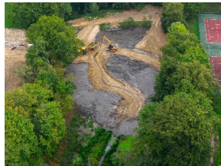
2025 - Travaux d'effacement de l'étang de la Cholière - Orvault
